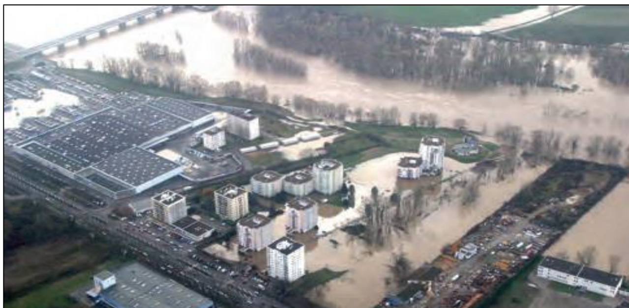
Photo vue aérienne de la crue de décembre 2003 - Cité des Îles et hypermarché « CORA » à VICHY
